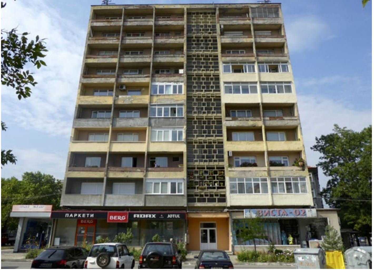
SET PÅ VEJ MOD BUSSTATIONEN I BLAGOEVGRAD
