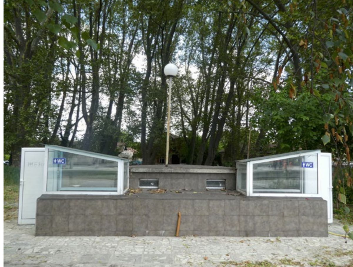
BANEGÅRDENS TOILET SER RET FLOT UD PÅ YDERSIDEN, MEN NEDE I DEN MØRKE KÆLDER VENTEDE EN GRUSOM STANK OG EN ULÆKKER SUPPE AF VAND OG PIS OG LORT
