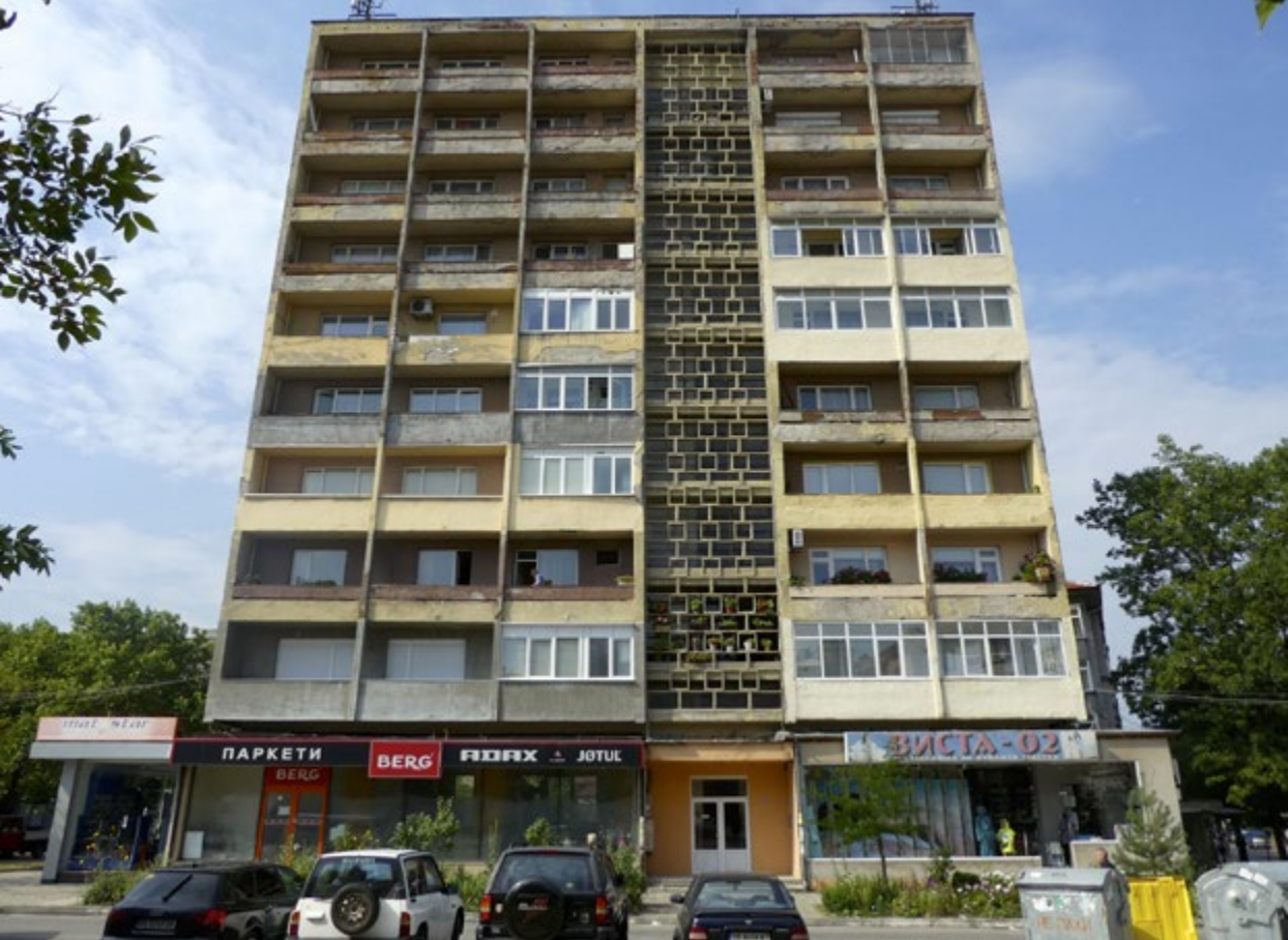
SET PÅ VEI MOD BUSSTATIONEN I BLAGOEVGRAD
